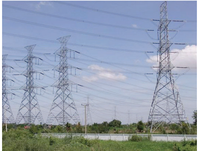
เสาไฟฟ้า
