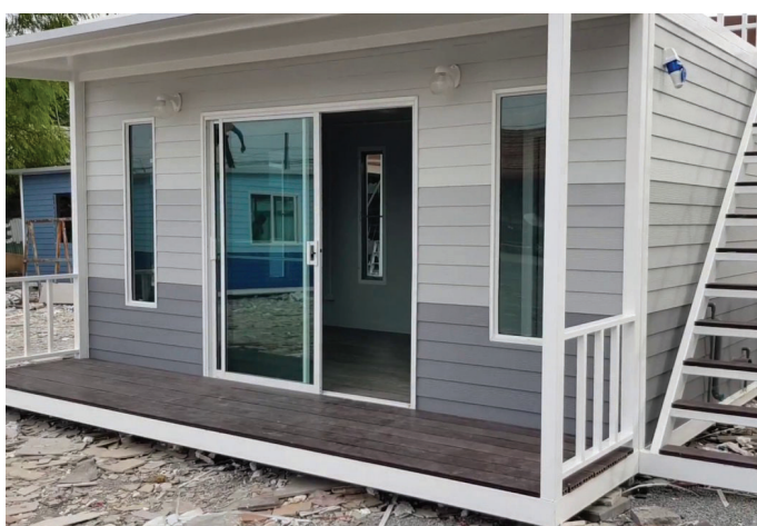
บ้านประกอบเสร็จ
