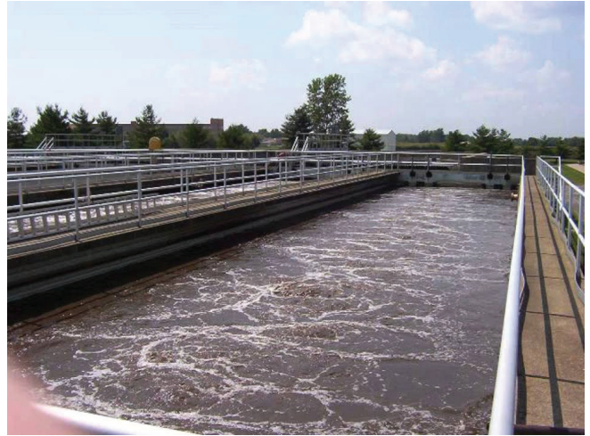
บ่อบำบัดน้ำเสีย
