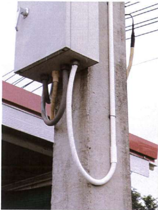
รูปภาพเดินท่อพร้อมร้อยสาย LAN UTP CAT๖
