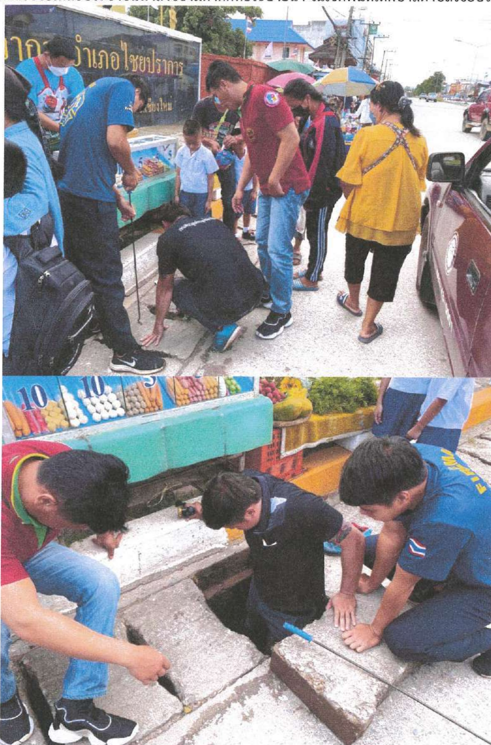
ภาพการช่วยเหลือประชาชนทำสิ่งของมีค่าตกท่อระบายน้ำ ในเขตพื้นที่เทศบาลตำบลไชยปราการ
