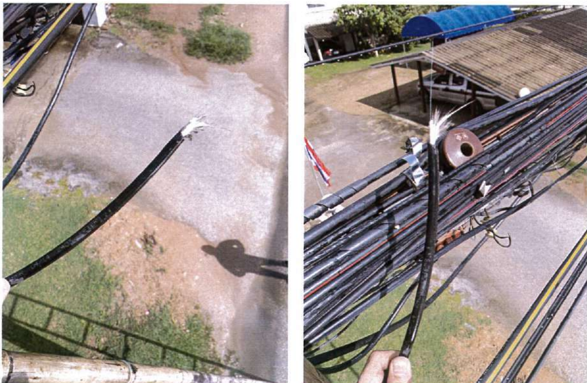
รูปภาพ สายสัญญาณ Fiber Optic ๖ Core ขาด ที่หน้าสถานีตำรวจภูธรอำเภอไชยปราการ
