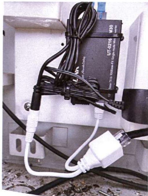
รูปภาพ Switching power supply ๑๒v ๒A และอุปกรณ์ต่อพ่วงภายในตู้เก็บอุปกรณ์
