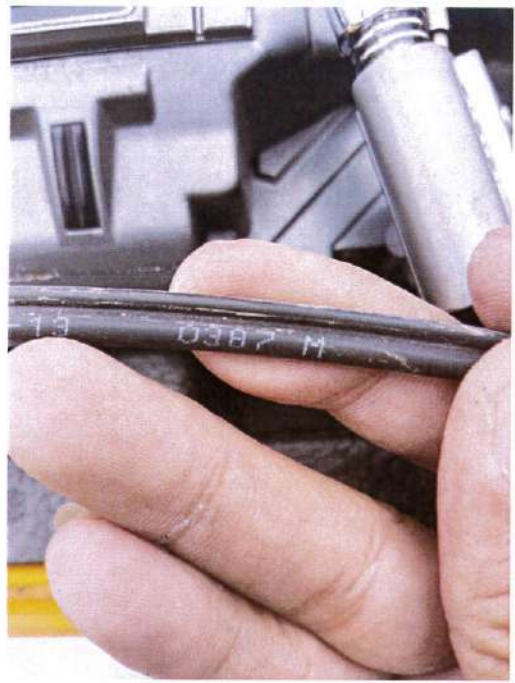
รูปภาพ เลขมาร์คสาย หัว-ท้าย ของสายสัญญาณ Fiber Optic ๑ Core
