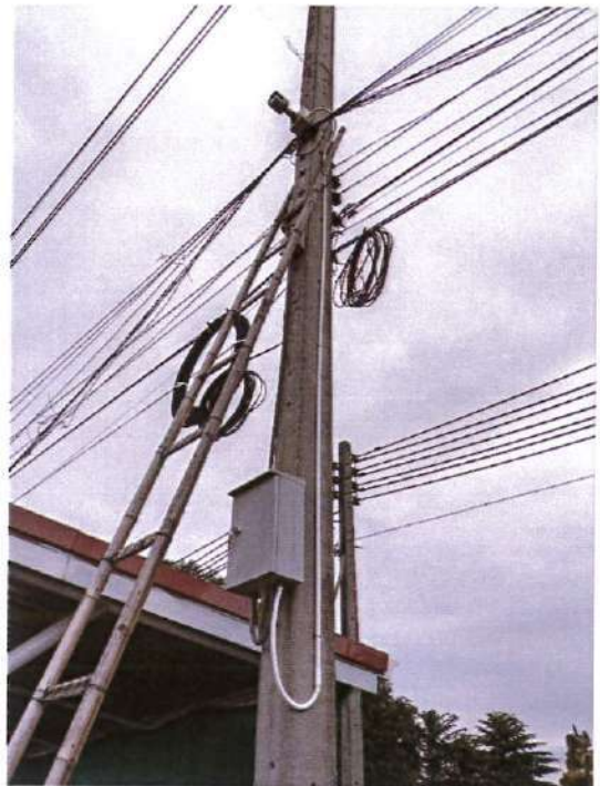
รูปภาพย้ายชุดกล่องพร้อมบล็อกกันน้ำขึ้นไปอีก ประมาณ ๑ เมตร
