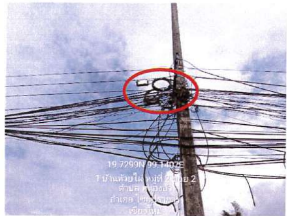
รูปภาพการเก็บสาย Cable Fiber Optic ที่ตัดต่อเสร็จเรียบร้อยแล้ว (หัว-ท้าย)
