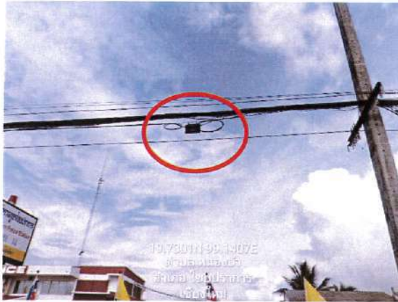
รูปภาพการเก็บสาย Cable Fiber Optic ที่ตัดต่อเสร็จเรียบร้อยแล้ว (หัว-ท้าย)
