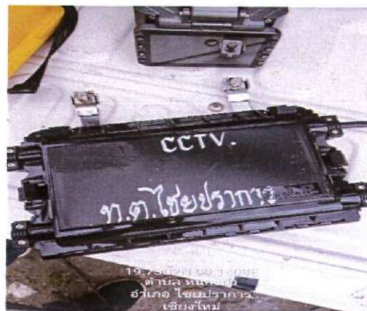
รูปภาพการเก็บสาย Cable Fiber Optic ที่ตัดต่อเสร็จเรียบร้อยแล้ว (หัว-ท้าย)
