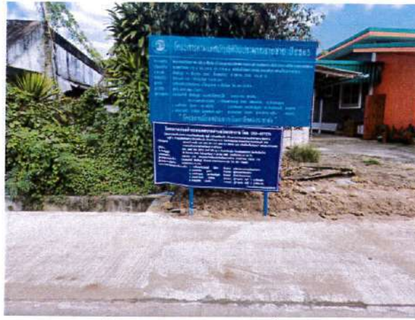
๑๑.โครงการ ก่อสร้างถนนคอนกรีตเสริมเหล็ก บริเวณซอย ๗ หมู่ที่ ๕ บ้านอ้าย ตำบลศรีดงเย็น งบประมาณ ๑๔๕,๑๐๐ บาท
