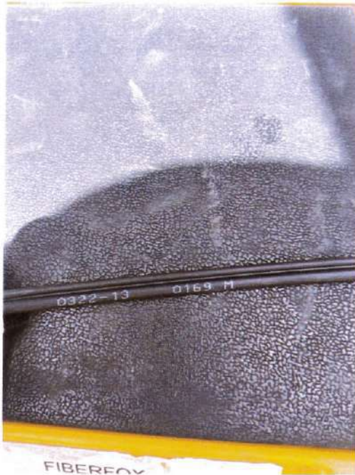
รูปภาพ เลขมาร์คสาย หัว-ท้าย ของสายสัญญาณ Fiber Optic ๑ Core
